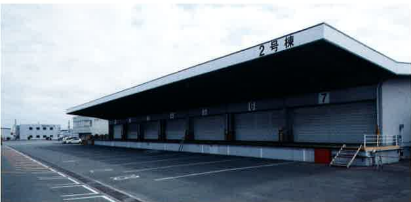
コンテナ・フレート・ステーション (CFS2号棟)
